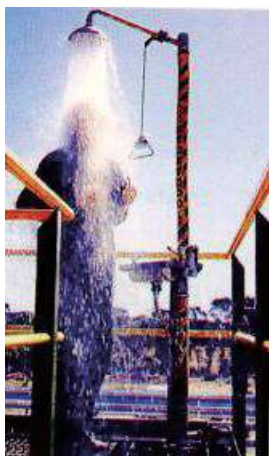
图 7-1 紧急冲淋装置
